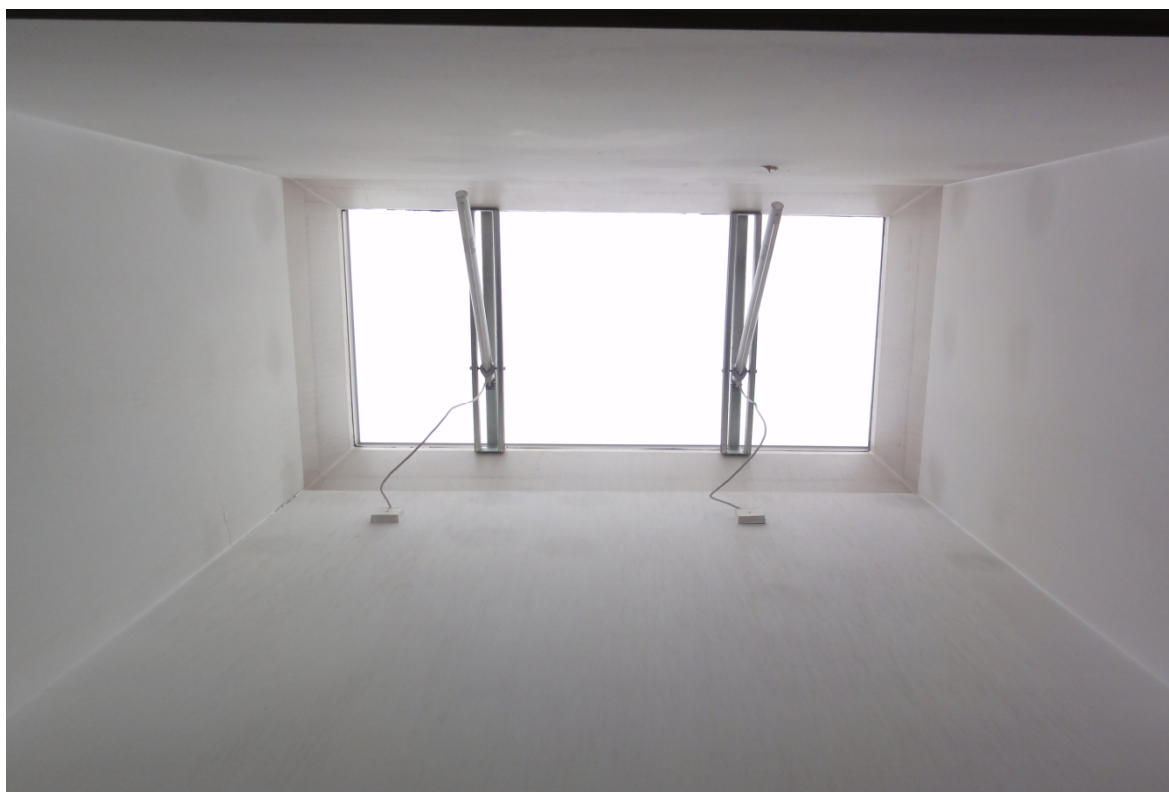
Zdjęcie nr 5: Kłapa oddymiająca w klatce schodowej nr 2
