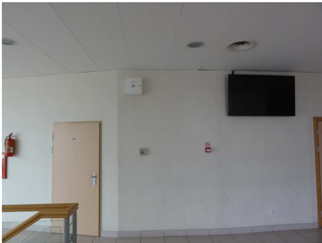
Zdjęcie nr 2: Istniejąca centrala oddymiania typu D+H RZN dla klatki schodowej nr 1
